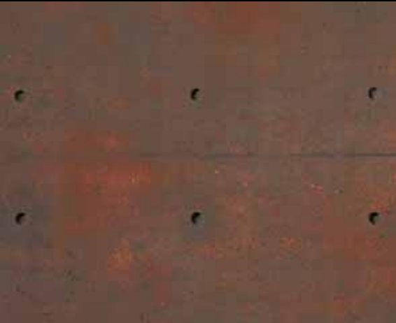
M-172 · Rusty Concrete Panel Panel Cemento Oxidado
